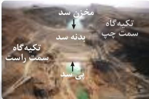
نمایی از بخش‌های مختلف یک سد
