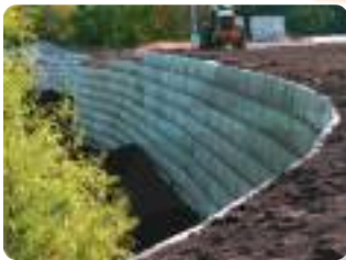
پایدارسازی شیب به روش دیوار حائل
