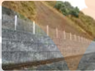
پایدارسازی شیب به روش دیوار حائل گابیونی (تور سنگی)
