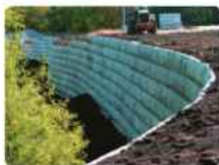
پایداری سازه شیب به روش دیوار حائل
