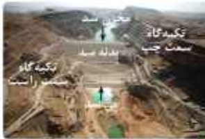
نمایی از بخش‌های مختلف یک سد
